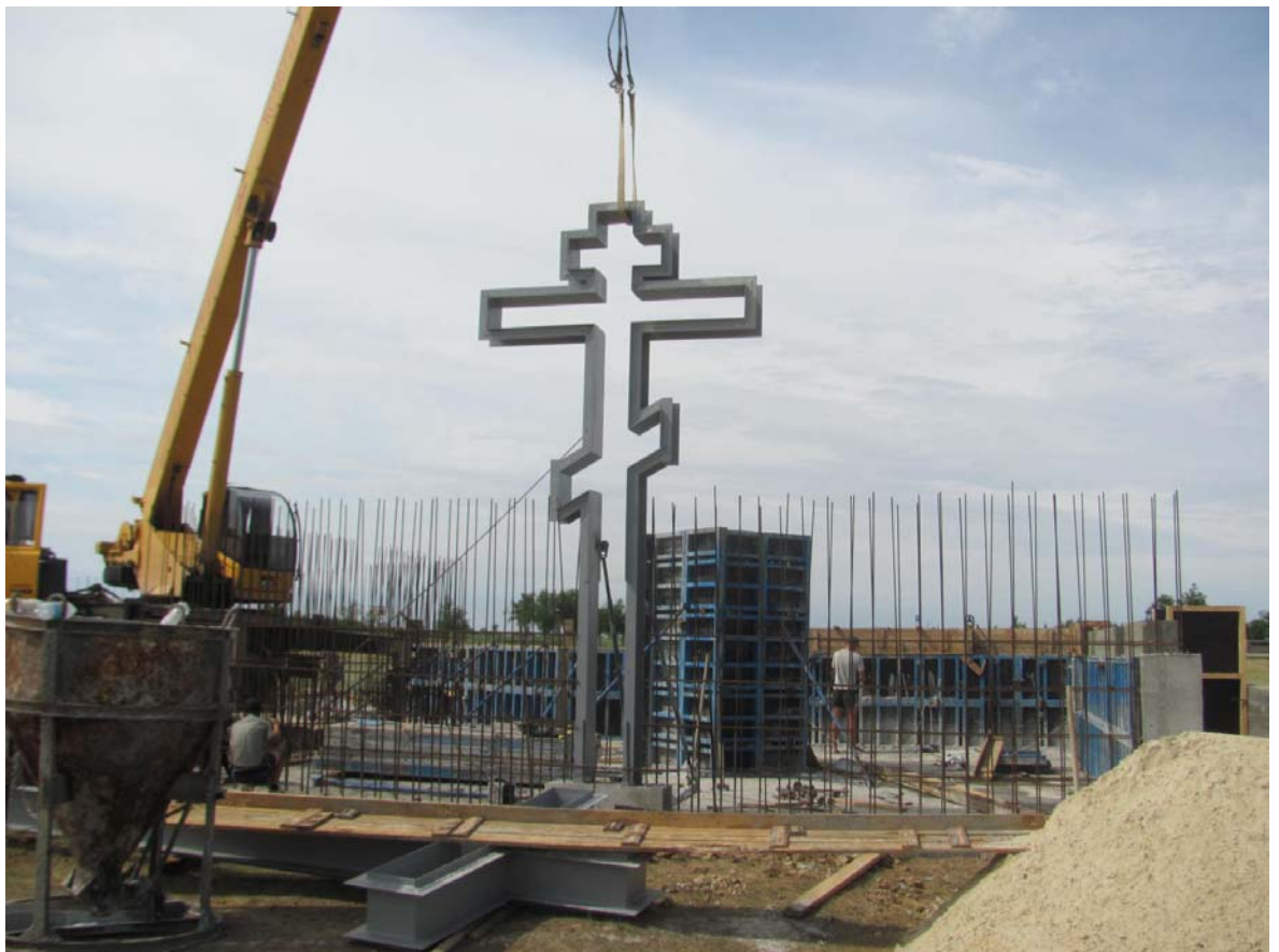
4. Монтаж металлической конструкции «Крест». Montage von Stahlbau "das Kreuz".
