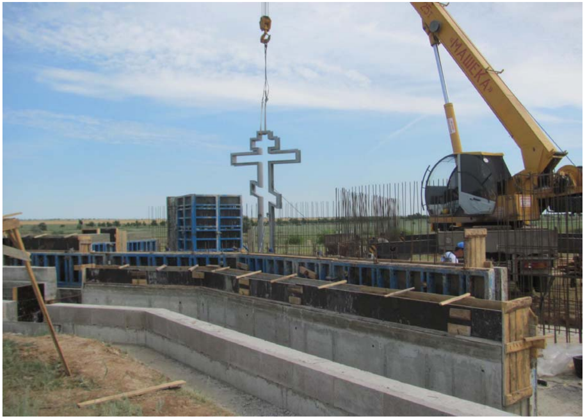
4. Монтаж металлической конструкции «Крест». Montage von Stahlbau "das Kreuz".
