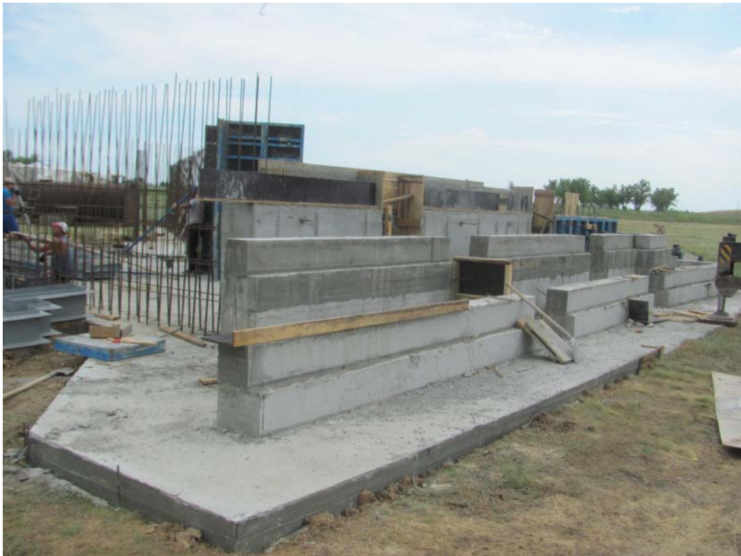
1. Укладка бетона. (Verlegung des Betons).
