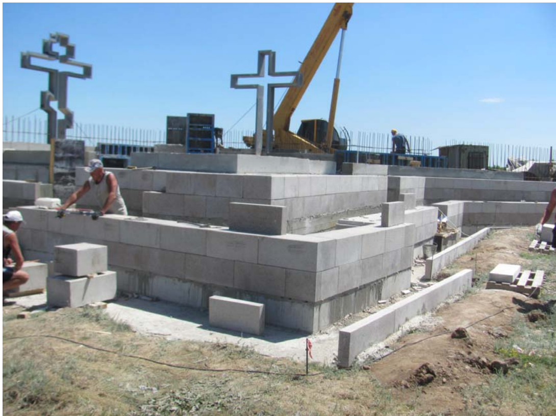
2. Укладка гранитных блоков. (Verlegung von Granitblöcken.)
