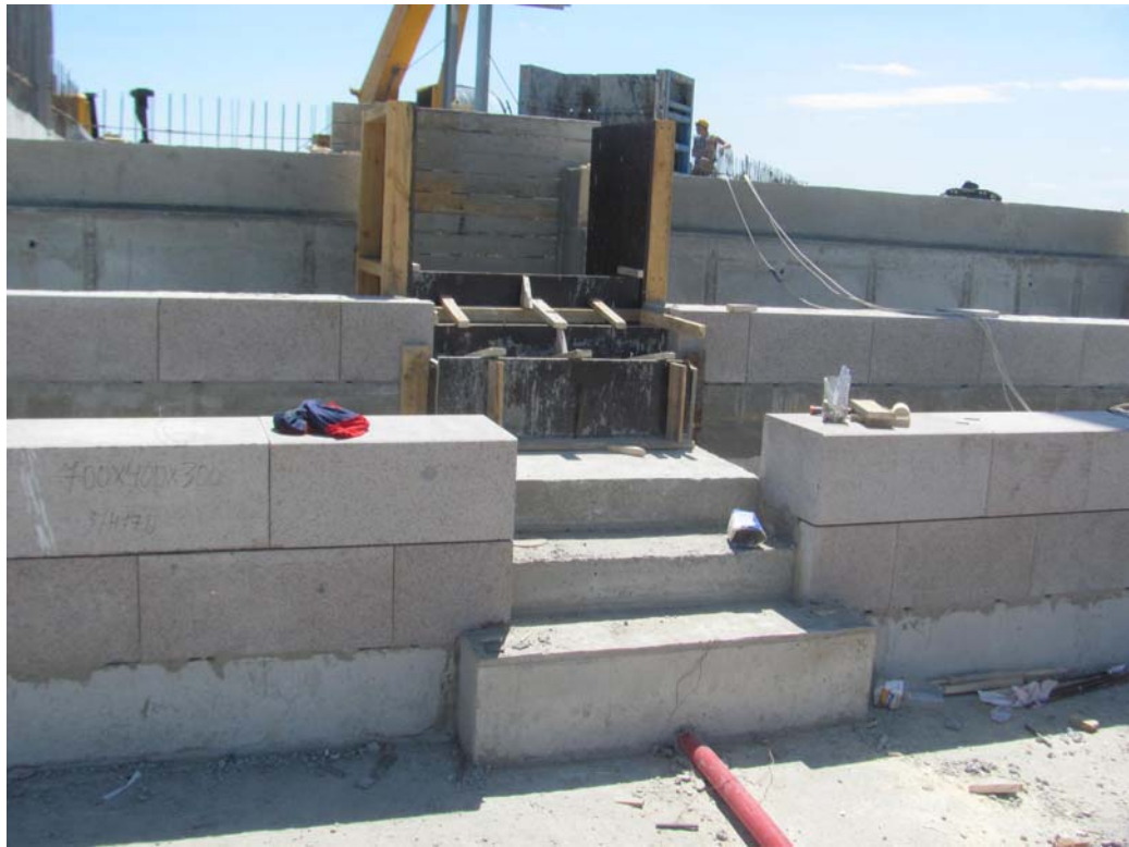
1. Бетонирование фундамента под ступени. (Betonieren des Fundamentes für die Stufen.)
