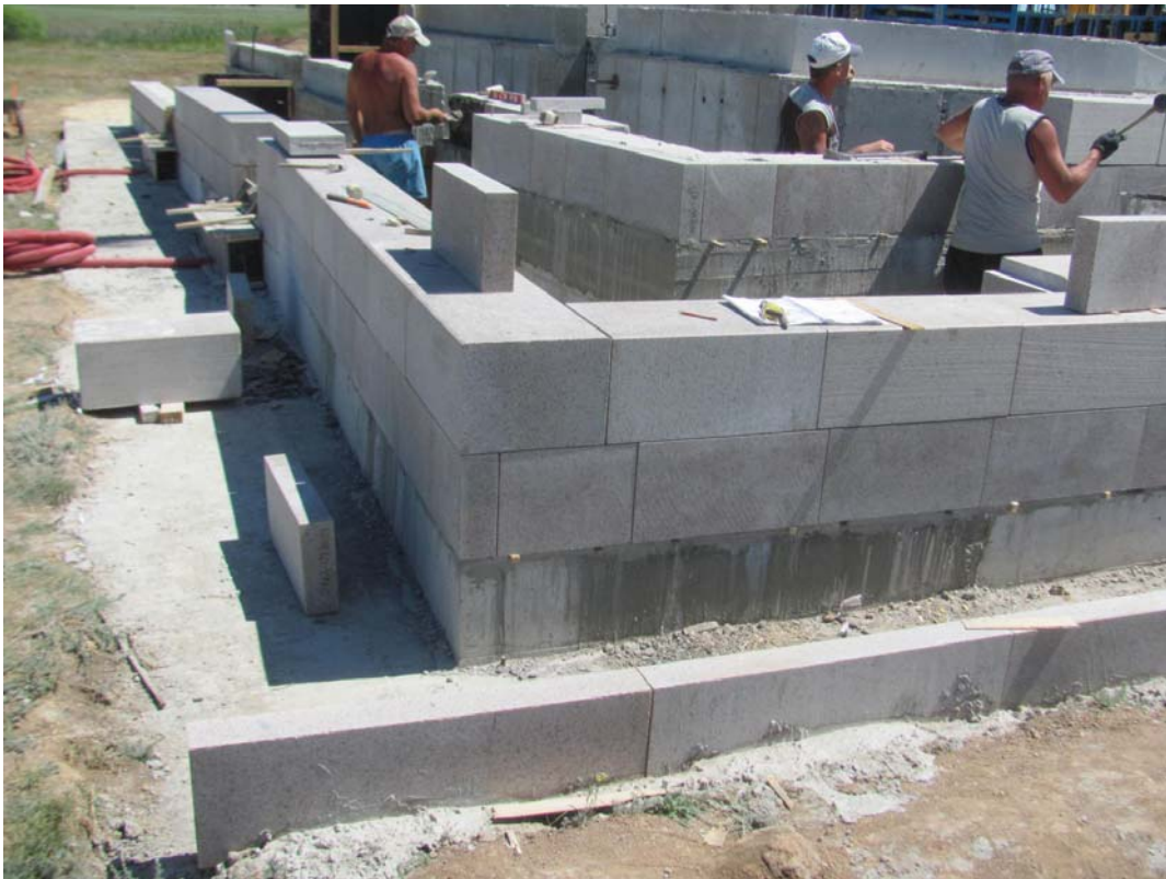
3. Укладка гранитных блоков.(Verlegung von Granitblöcken.)
