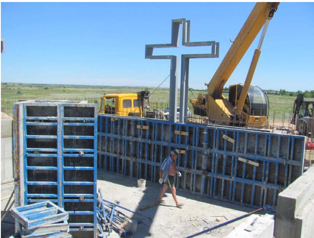
5. Бетонирование фундамента. (Betonieren des Fundamentes.)
