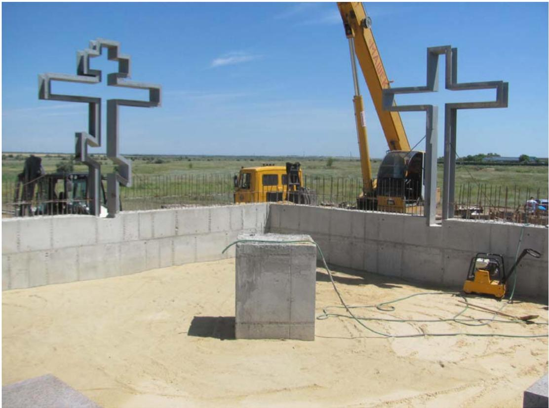
Засыпка и уплотнение песком. (Verfüllung und Verdichtung mit Sand.)
