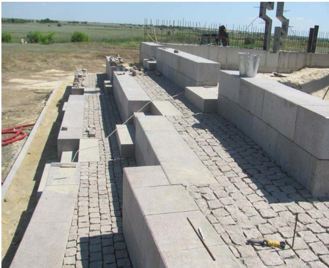
Укладка брусчатки и гранитных блоков. (Verlegung von Pflastersteinen und Granitblöcken.)
