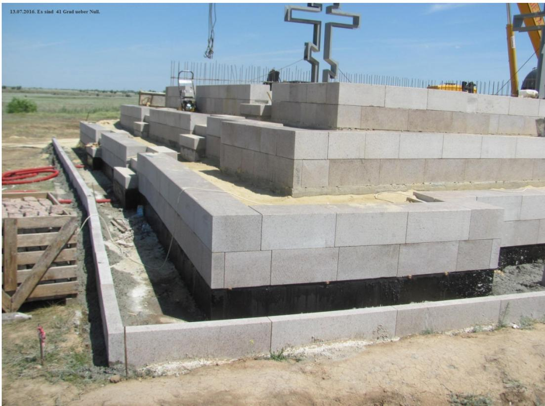
Засыпка и уплотнение песком. Гидроизоляция фундамента.
