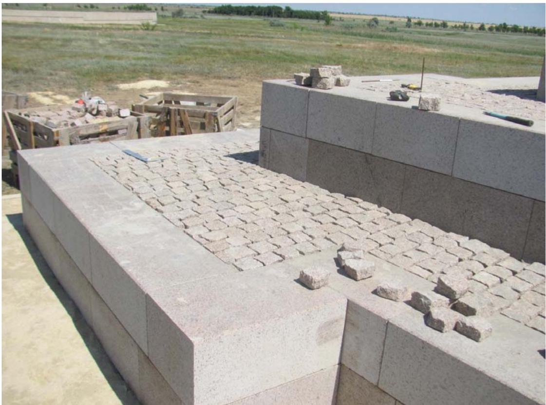
Укладка брусчатки и гранитных блоков. (Verlegung von Pflastersteinen und Granitblöcken.)
