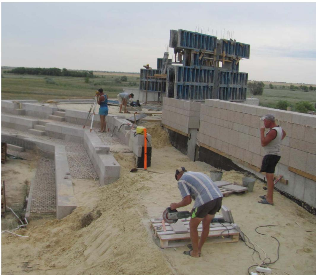
6. Засыпка песком с уплотнением и облицовка стен гранитными плитами. (Verfüllung vom Sand, die Verdichtung des Sandes und die Verkleidung der Wände von den Granitplatten.)
