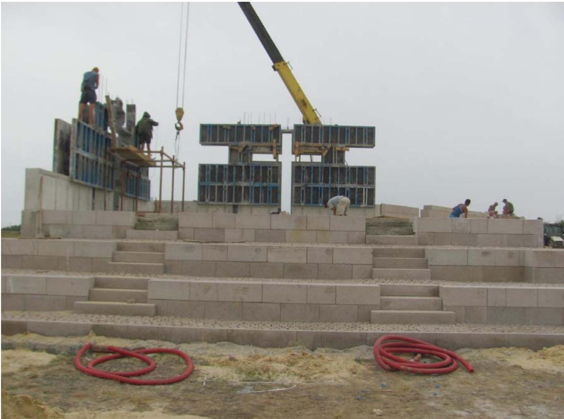
5. Установка опалубки стен с крестами.( Die Anlage des Verschalens der Wände mit den Kreuzen.)
