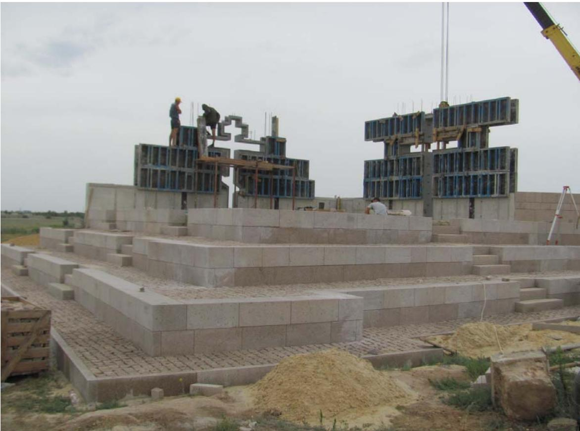
4. Установка опалубки стен с крестами. (Die Anlage des Verschalens der Wände mit den Kreuzen.)
